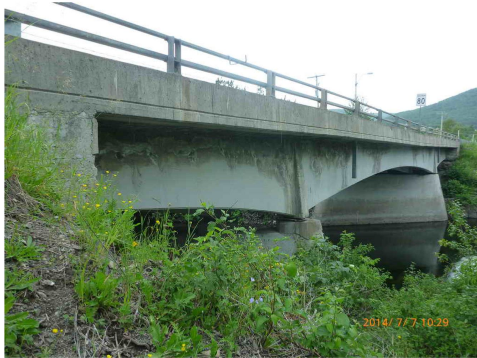
Figure 1 Présentation de l'ouvrage existant
