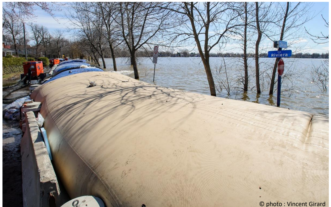
Exemple d'une digue d'eau – Ville de Laval
