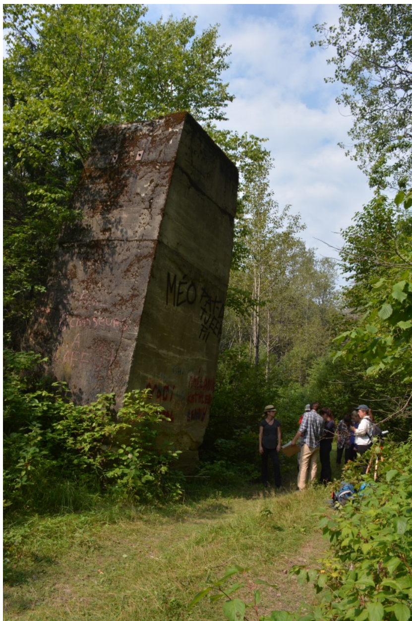
Figure 22. La cheminée des chaudières de la scierie de Milnikek.
