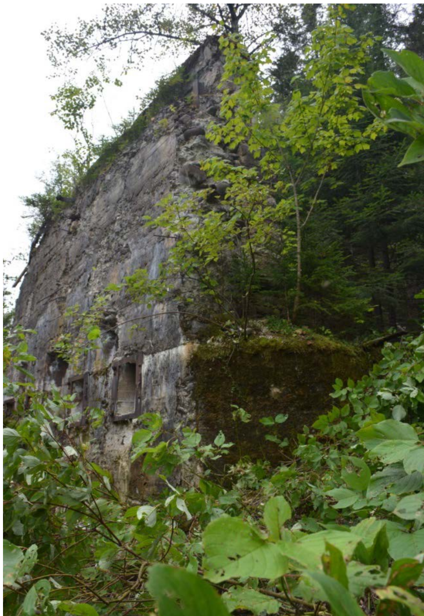
Figure 24. Façade du brûleur de la scierie de Milnikek.
