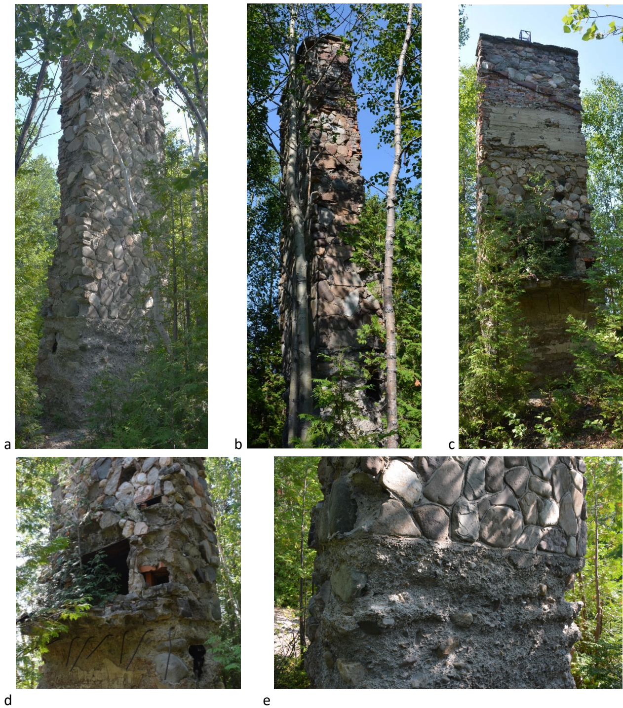
Figure 14. La cheminée de l'Ancien Chalet à Soucy : a) parements ouest, b) sud et c) est ; d) le foyer ; e) détail de la fondation de béton.
