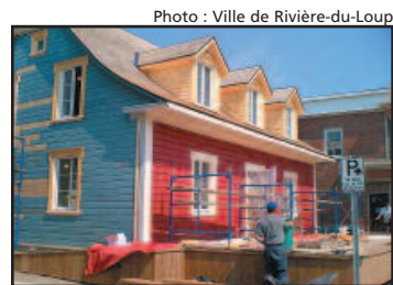
Photo : Ville de Rivière-du-Loup Une petite vitrine en avancée peut parfois remplacer les fenêtres d'origine sans dénaturer la façade et son cachet ancien.
