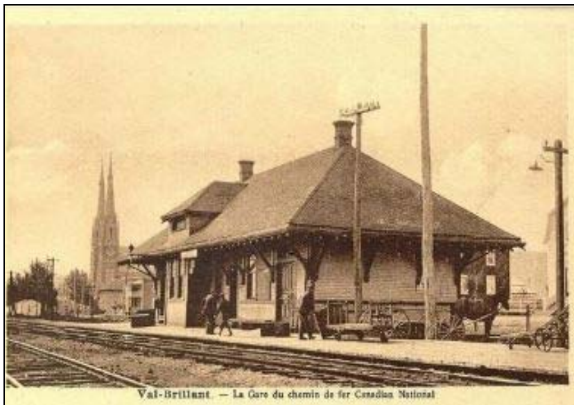
Figure 45. Église et presbytère de Val-Brillant et gare de l'Intercolonial puis du Canadien National à Val-Brillant, démolie en 1986 (Cartes postales)
