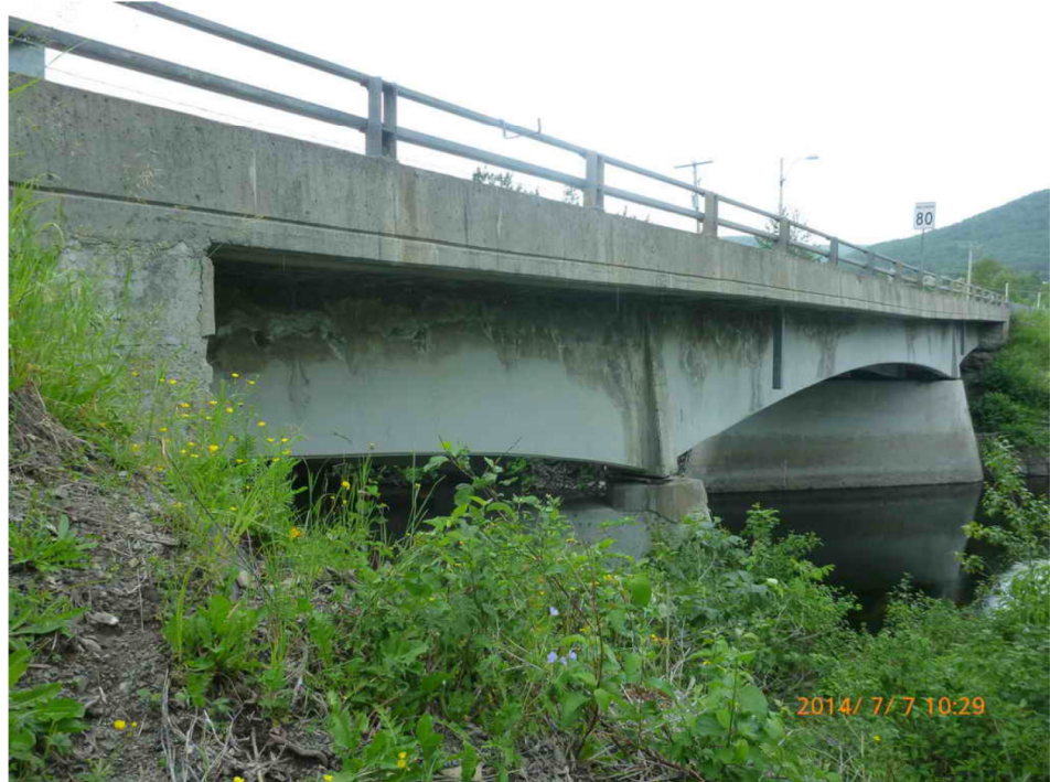
Figure 1 Présentation de l'ouvrage existant
